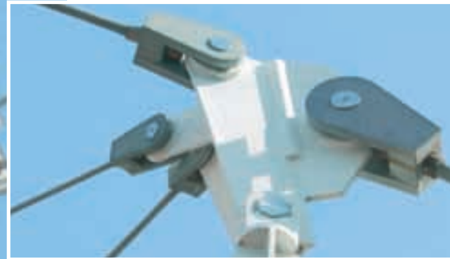
Filigran olmasına rağmen son derece yüklü: Tavan konstrüksiyonunun taşıyıcı halat bağlantısı
