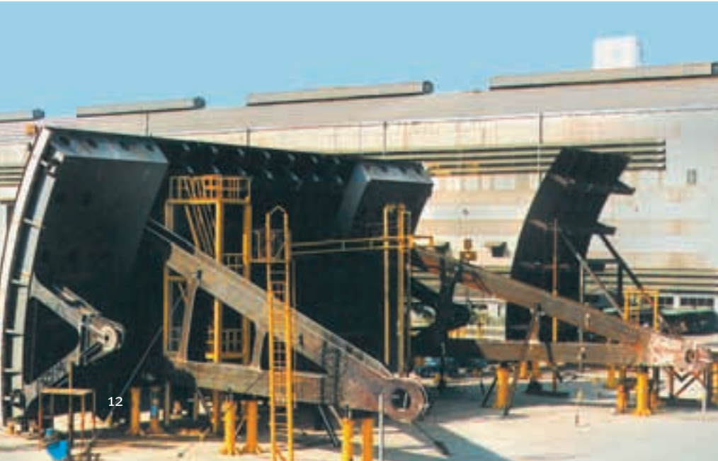
Devasa: Saemangum barajındaki segment koruyucuları 15 metre yüksekliğinde ve 30 metre genişliğinde
