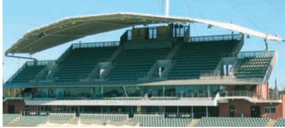
Sydney'deki State Hockey Centre: Tavan kenarı ve direklerdeki tüm halat yönlendirme noktaları ELGOGLIDE®-kaplı mafsallı yataklarda yataklanmıştır
