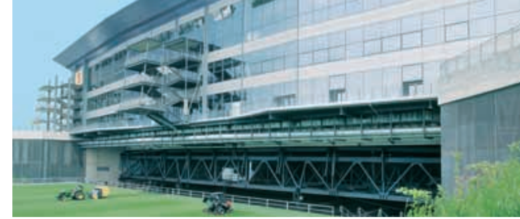
Arena „AufSchalke“, Gelsenkirchen: Burada stadyumun önünde bulunan oyun sahası, stadyumun içerisine olan 300 metrelik mesafeyi altı saat içinde geçiyor
