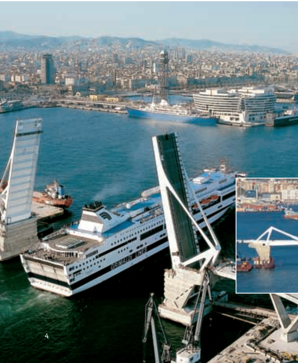
Barcelona. Halen dünyanın en büyük çiftli katlanır köprüsü, 670 mm delik çapına sahip bakım gerektirmeyen büyük mafsallı yataklar üzerinde hareket ediyor
