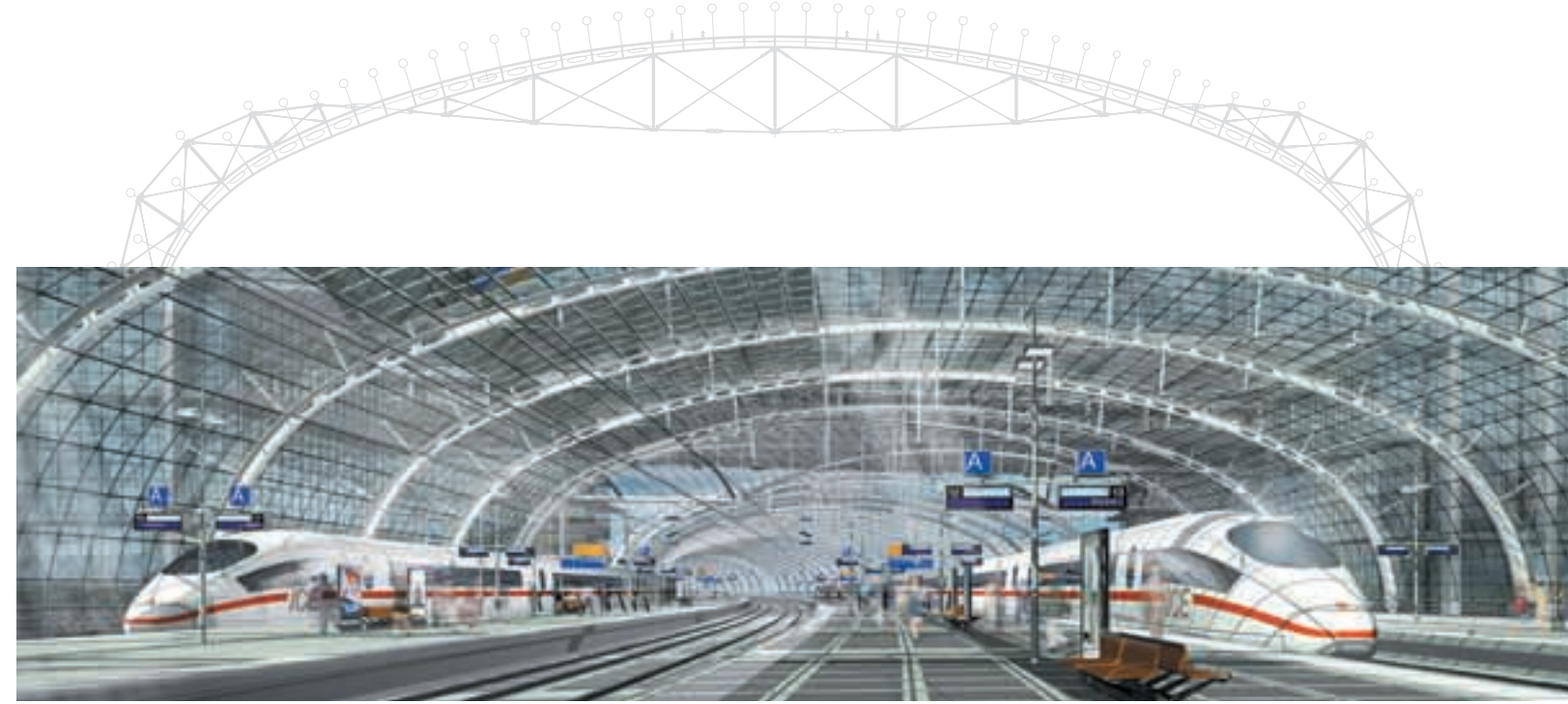
Lehrter Tren Garı, Berlin: Avrupa'nın en büyük tren garının tavan konstrüksiyonu yaklaşık 300 metrelik peron üzerinde bulunuyor ve çok sayıda ELGES mafsallı yatak/pim sistemleri içeriyor (Resim bilgisayar simülasyonu © Archimotion, Berlin)
