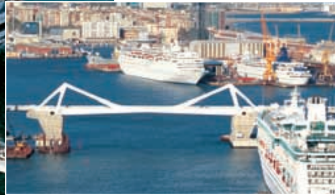
Barcelona. Halen dünyanın en büyük çiftli katlanır köprüsü, 670 mm delik çapına sahip bakım gerektirmeyen büyük mafsallı yataklar üzerinde hareket ediyor
