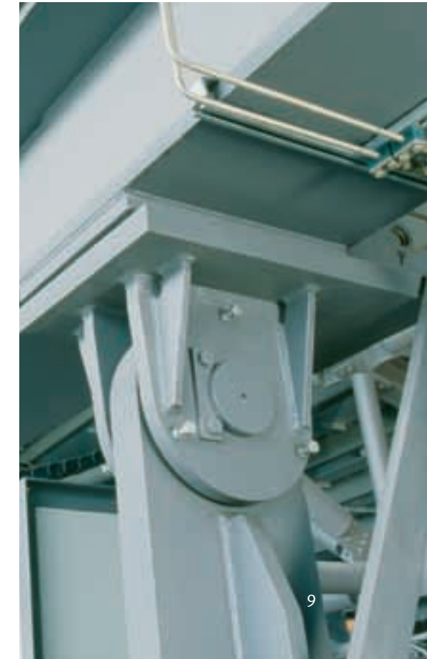
Tribün altındaki direklerde bulunan mafsallı yataklar: Yukarı katlanmış konumdayken oyun çiminin içeri ve dışarı sürülmesini sağlıyorlar.
