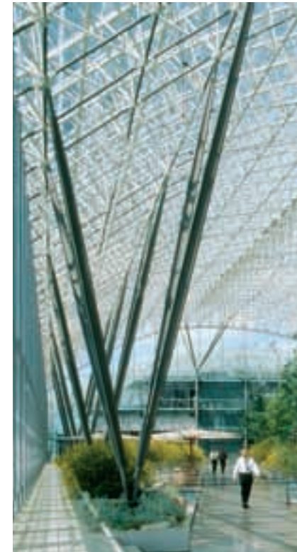
Büyüleyici: Taşıma tertibatı konstrüksiyonunun tüm momentsiz yönlendirme noktalarında ELGES adı geçiyor
